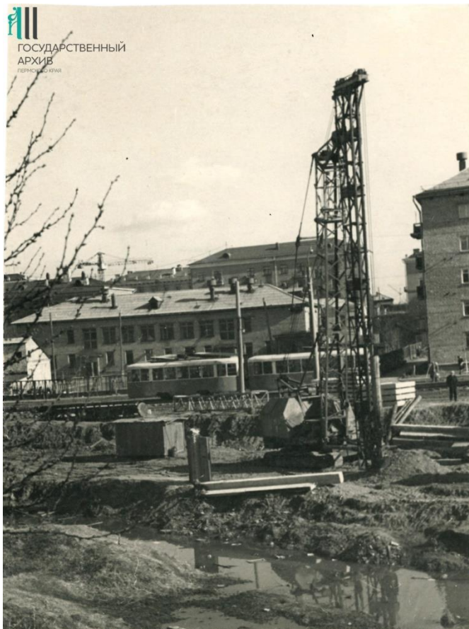
Строительство подземного коллектора по ул. Коммунистической. 1960-е гг.
