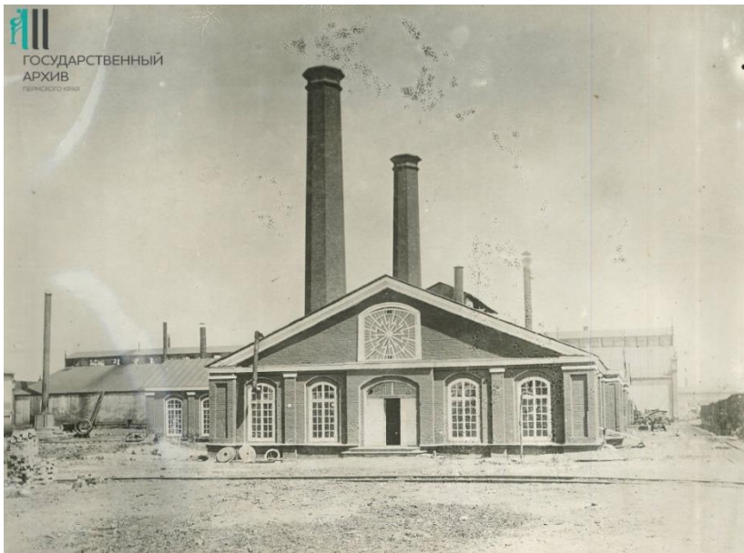
Электростанция Пермских пушечных заводов. 1889 г.
